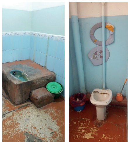
Die Toilettenanlagen im Spital in Choryakoron, Tadschikistan.
